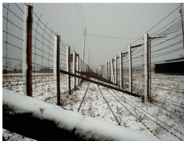
Barrières de sécurité.
